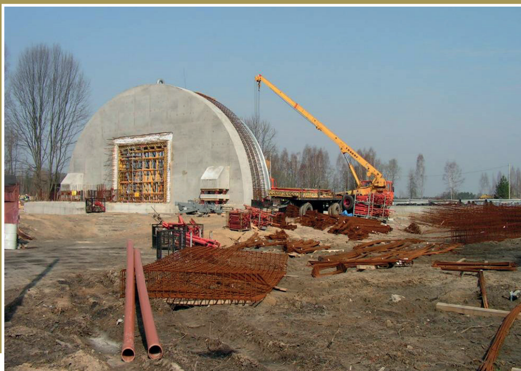
Fot. 9. Budowa schronohangarów w 32 BLT. Autor: Tomasz Miedziński.
