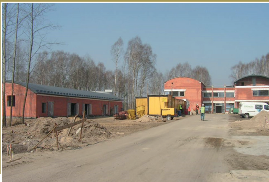
Fot. 8. Budowa domku dla personelu technicznego w 32. BLT. Autor: Tomasz Miedziński.
